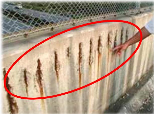
短い間隔で発生しているひび割れ
