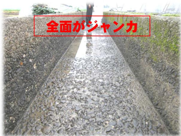
摩耗により骨材が露出し
