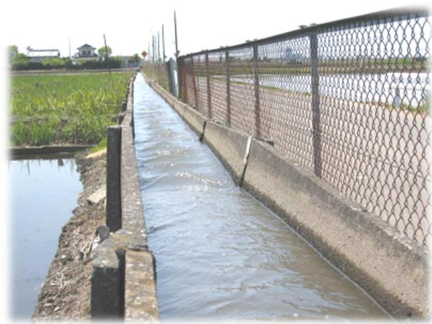
不同沈下による水路の変形
