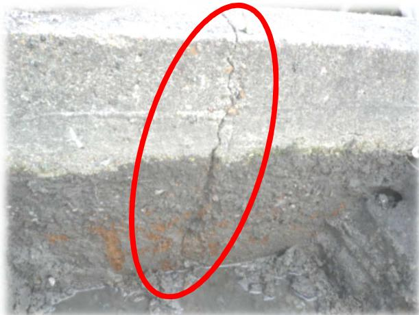
ひび割れから水田への漏水
