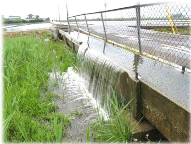
不同沈下による溢水
