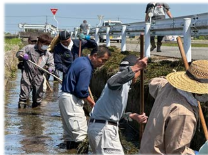
◇ 水路の泥上げ状況
