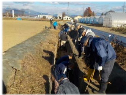
◇ 水路の泥上げ状況
