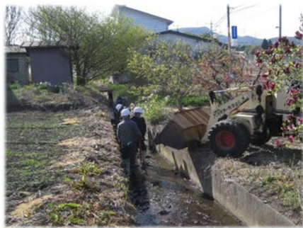
◇ 水路の泥上げ状況
