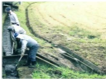
◇ 水路の泥上げ状況
