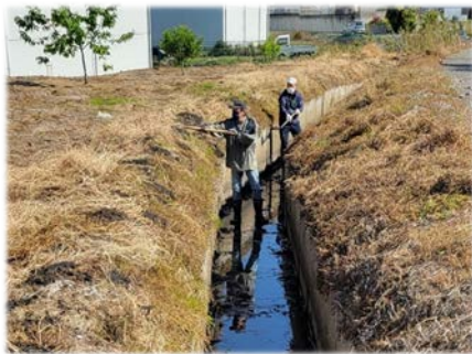
◇ 水路の泥上げ状況
