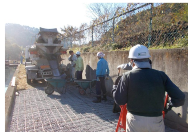
コンクリート舗装の直営施工
