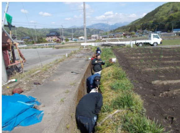
水路の泥上げ
