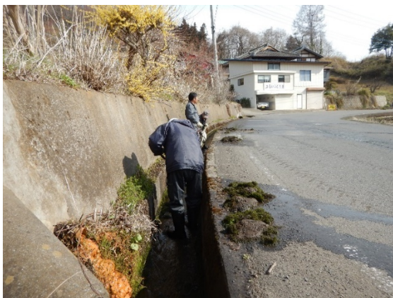
水路の泥上げ
