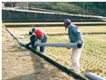
パイプの設置
