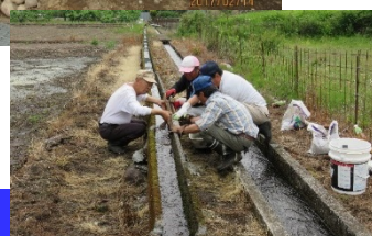
水路補修（直営）
