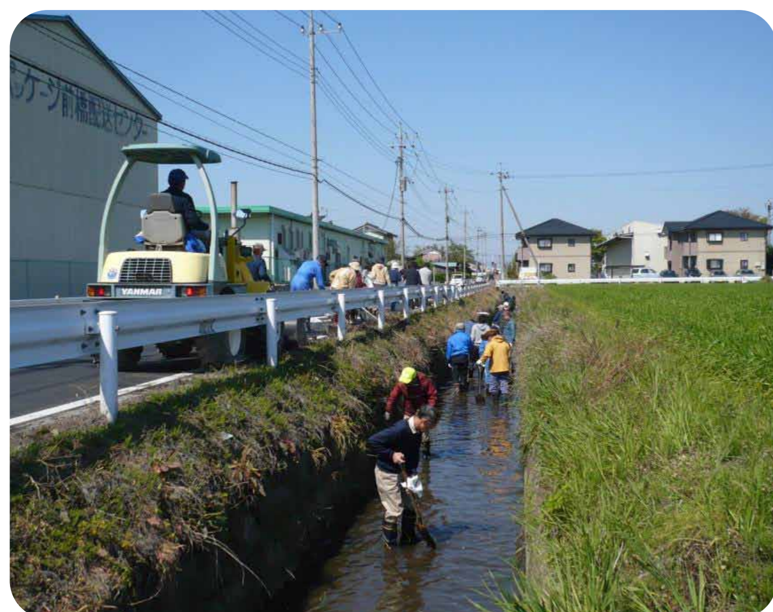
大型水路の土上げ
