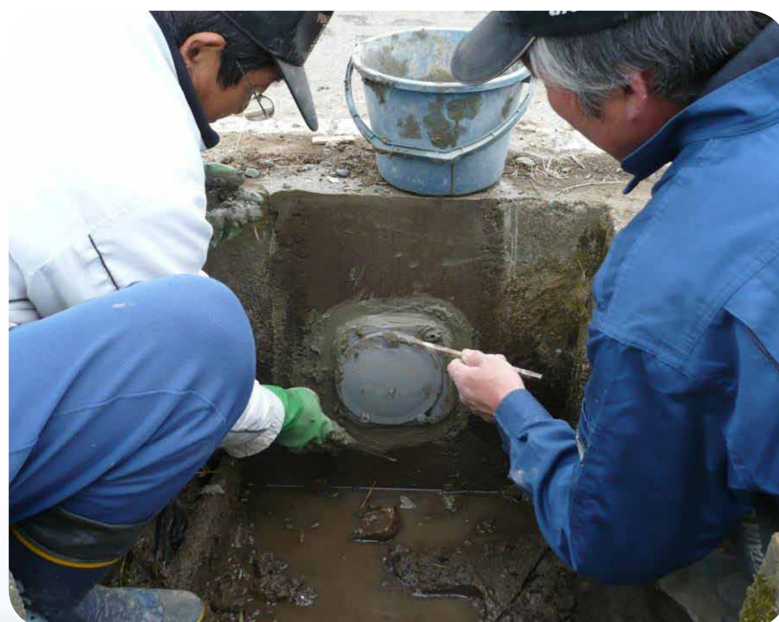
水口分水工の補修
