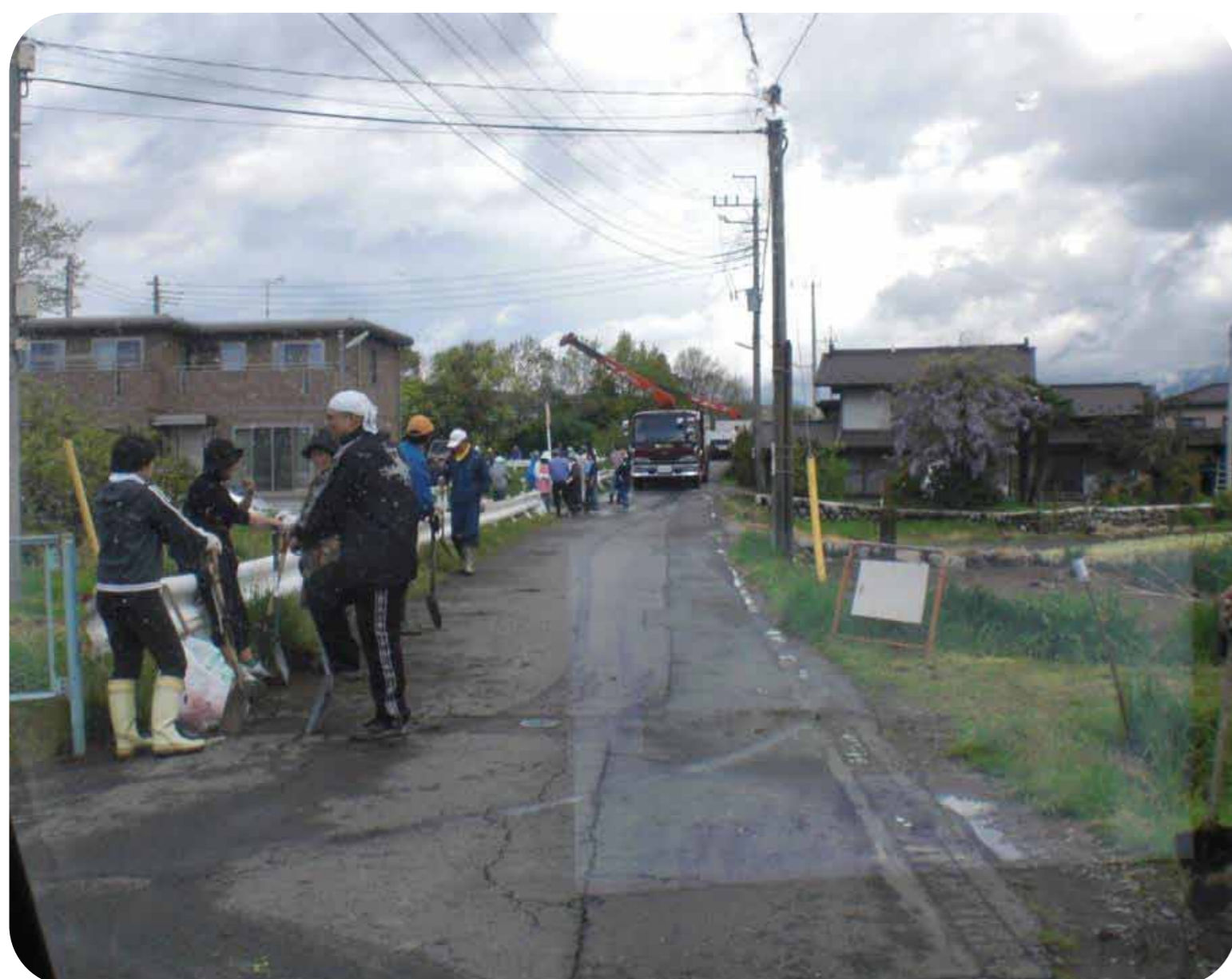
地域住民による施設点検・機能診断
