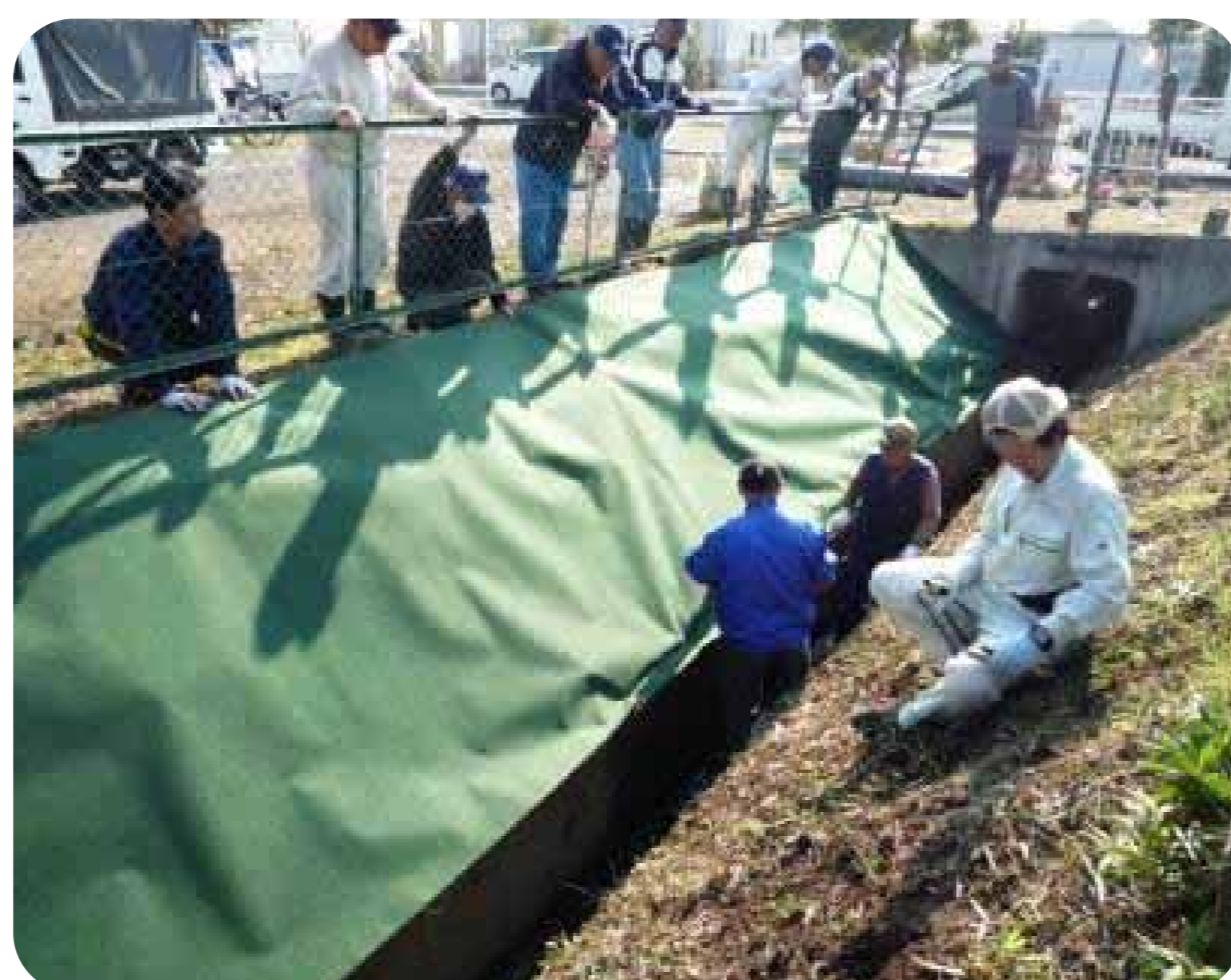
水路法面への防草シートの敷設
