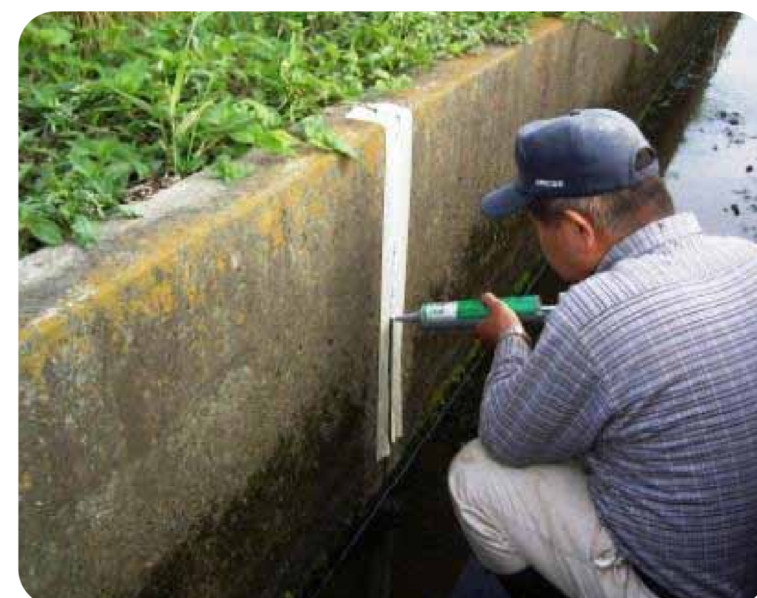
水路の目地補修
