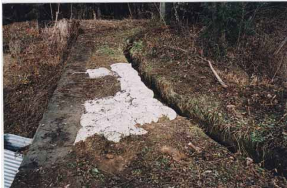
水路の補修完了
