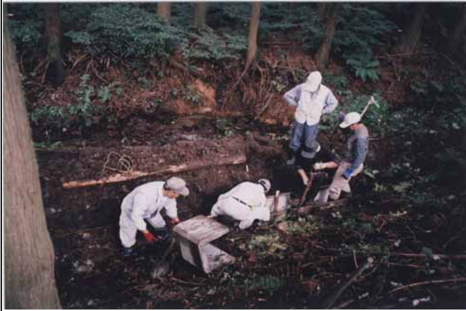
大清水用水 水路の補修
