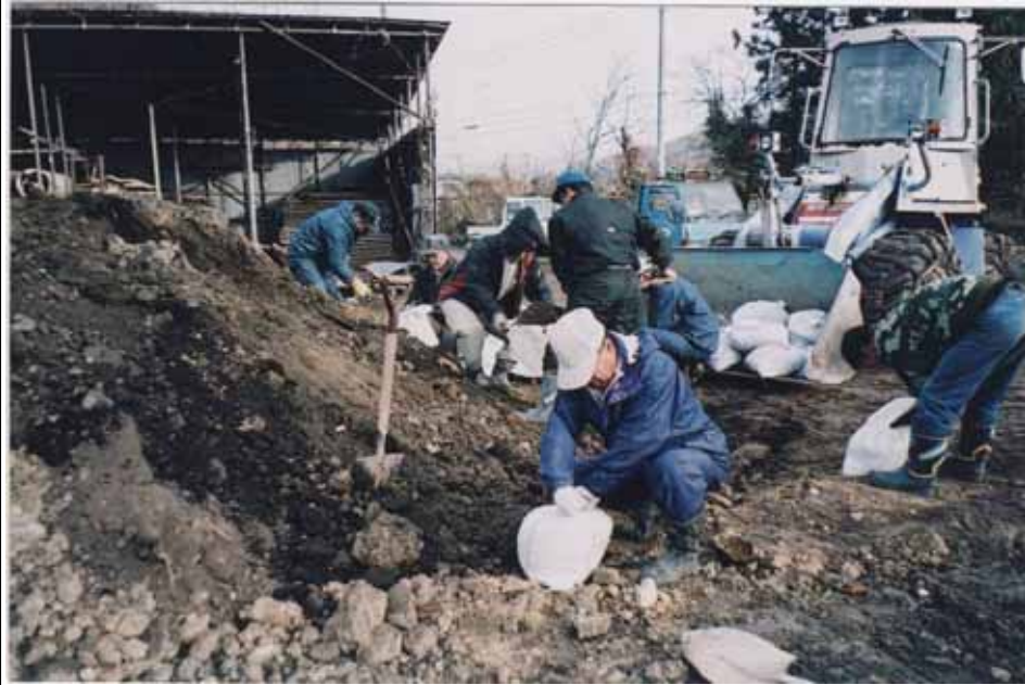
降雨災害で水路の補修
