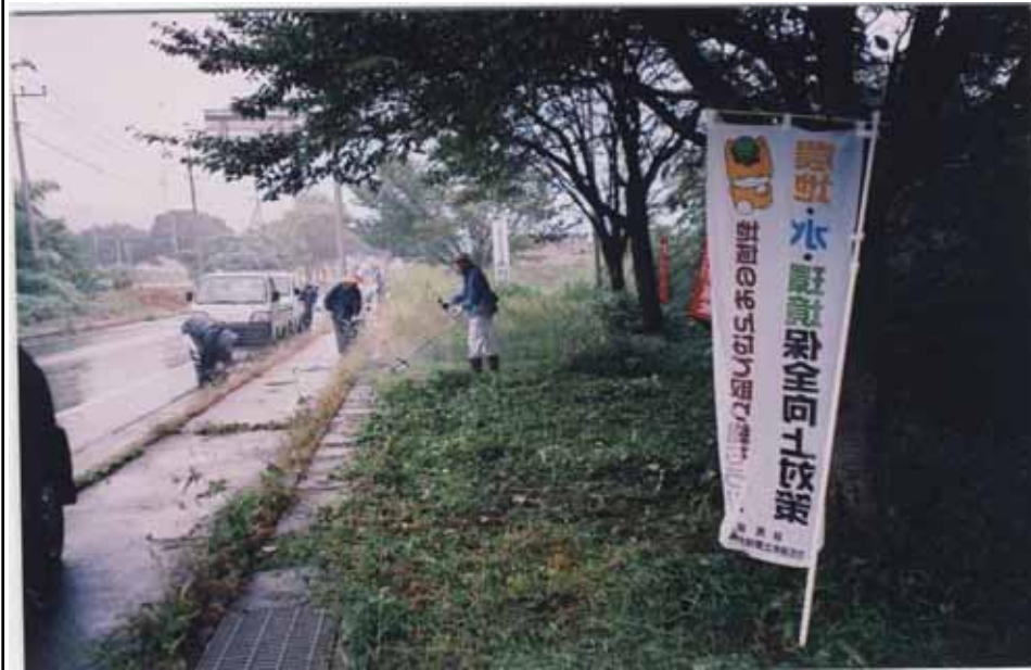
一般道路 歩道を含め草刈清掃作業
