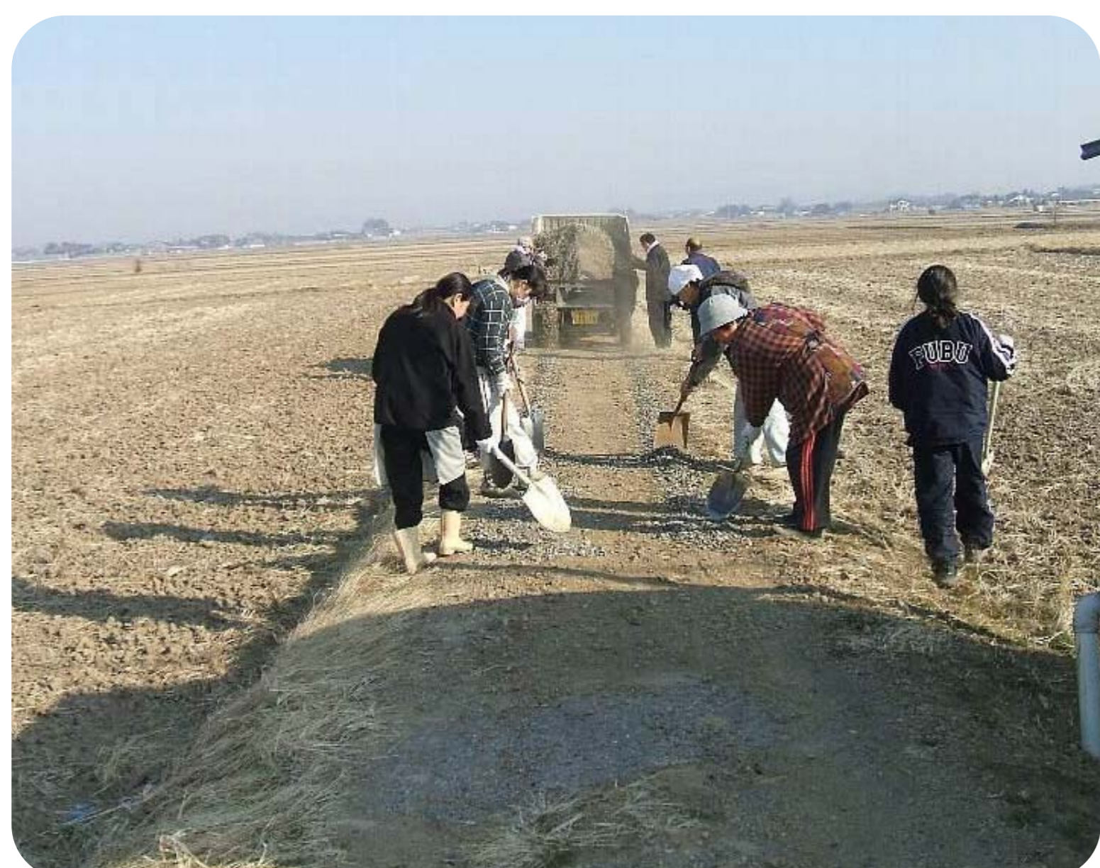
農道への砂利の補充作業
