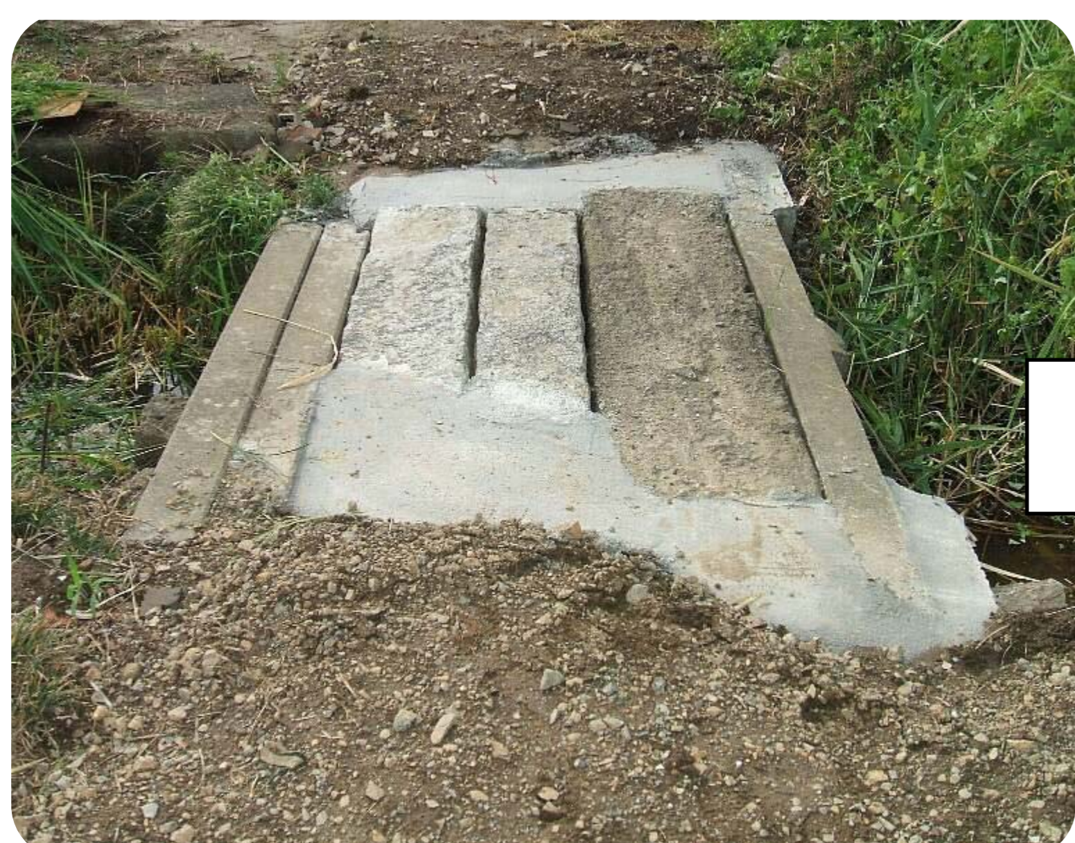
農道の橋の補強①
