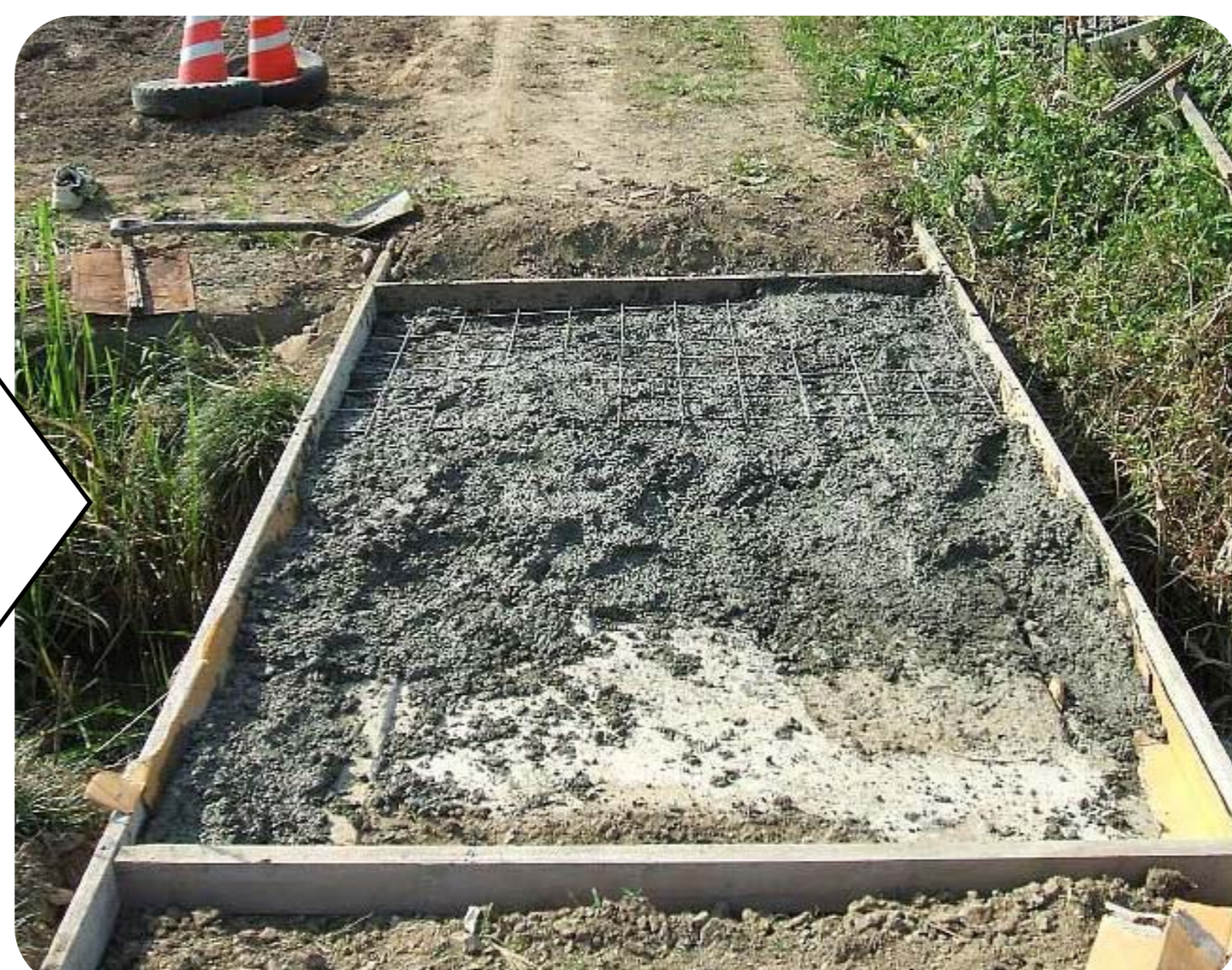
農道の橋の補強②
