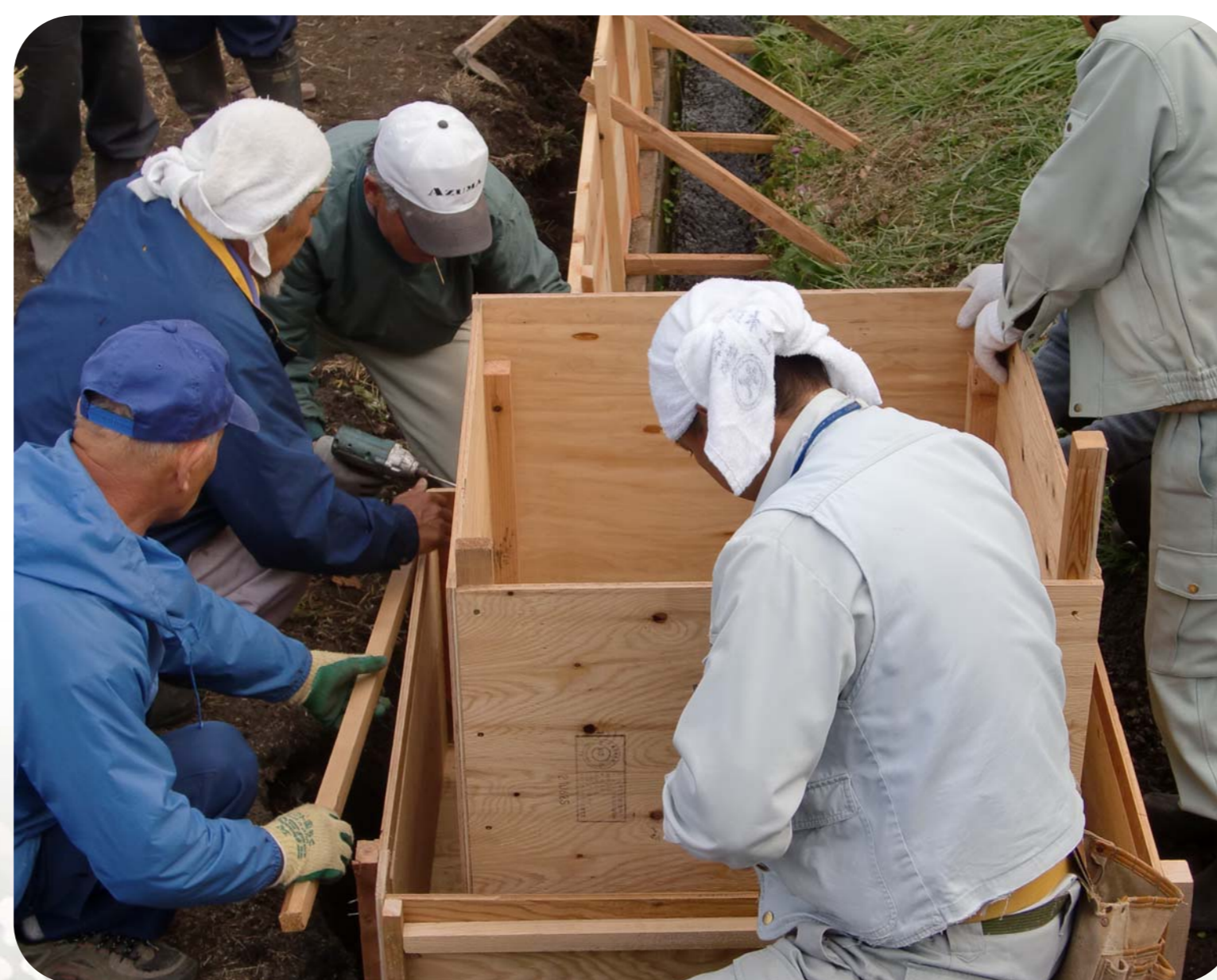
水路の水槽型枠設置作業
