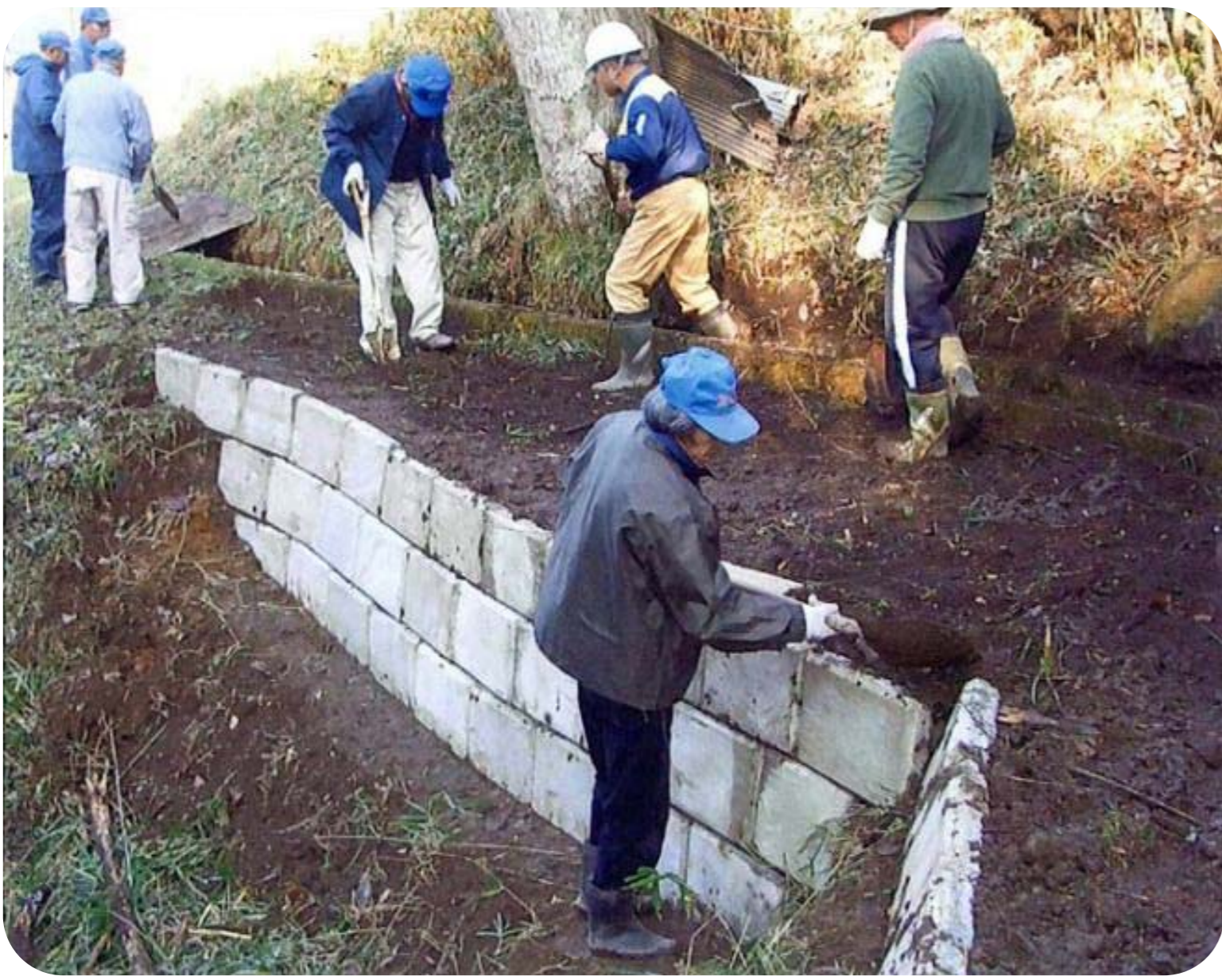
土留めブロック積み作業
