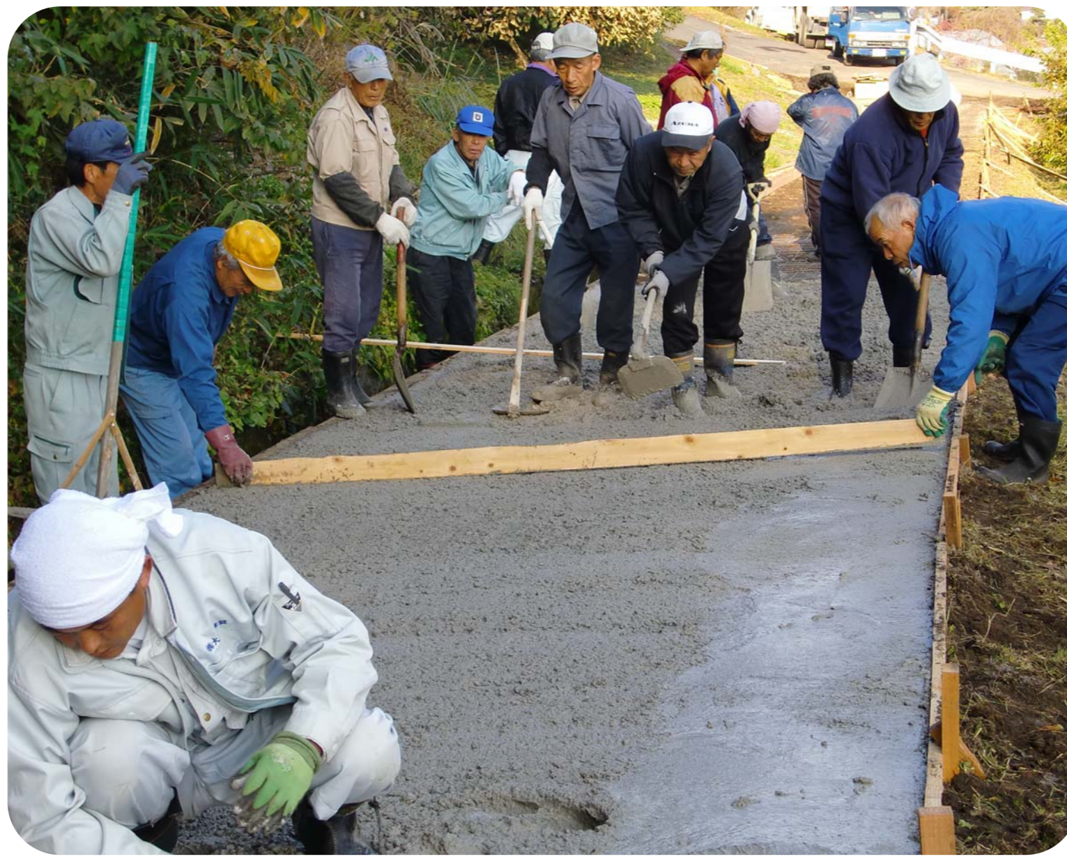
農道のコンクリート舗装
