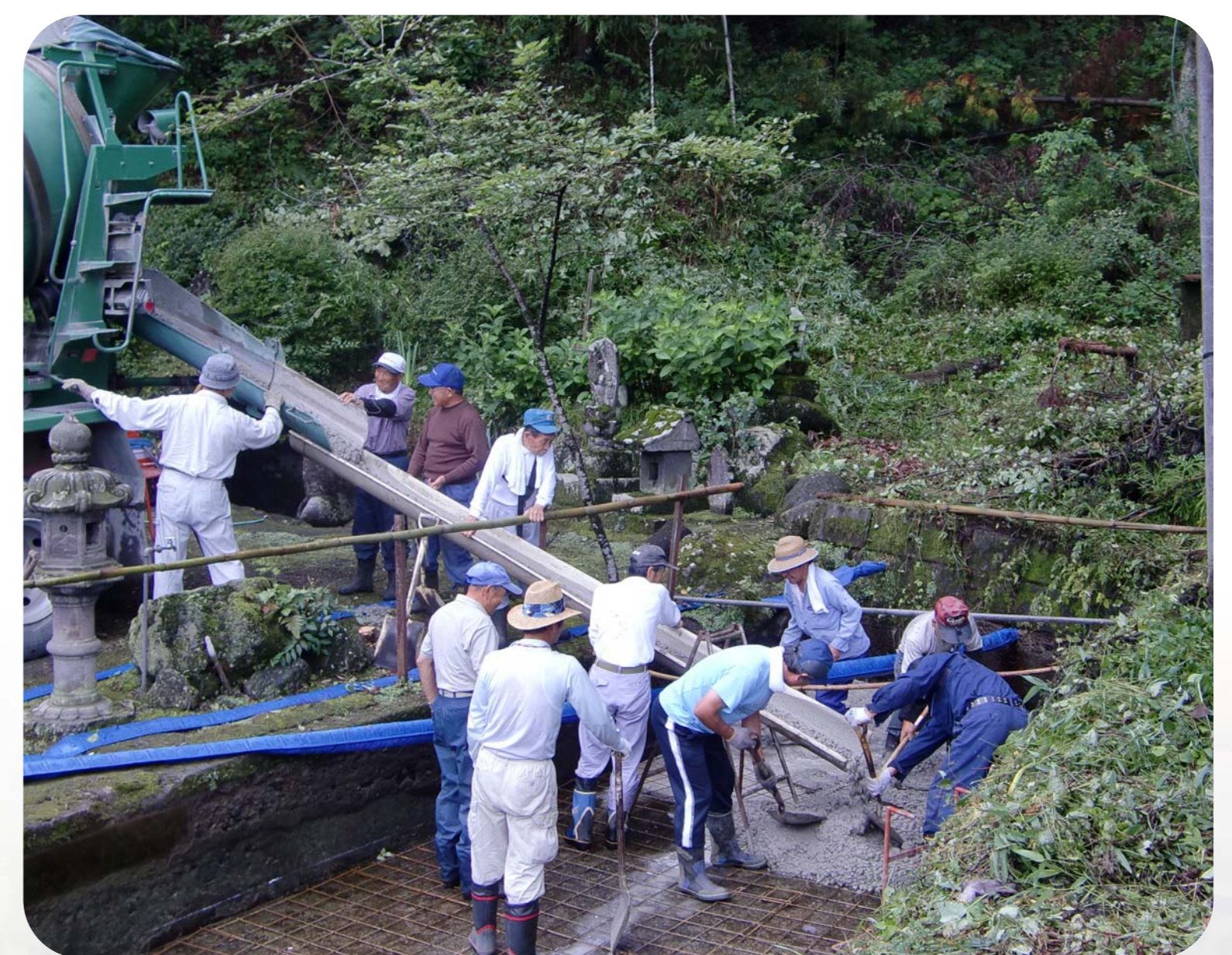
貯水池底版にコンクリート打設
