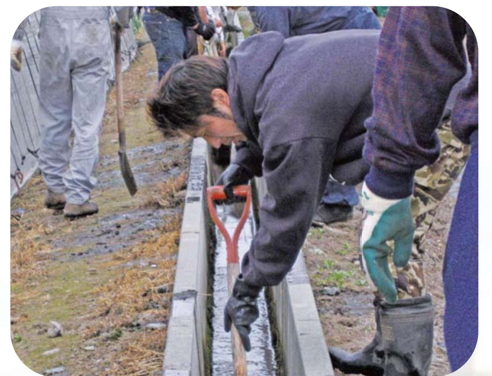
末端水路の泥上げ
