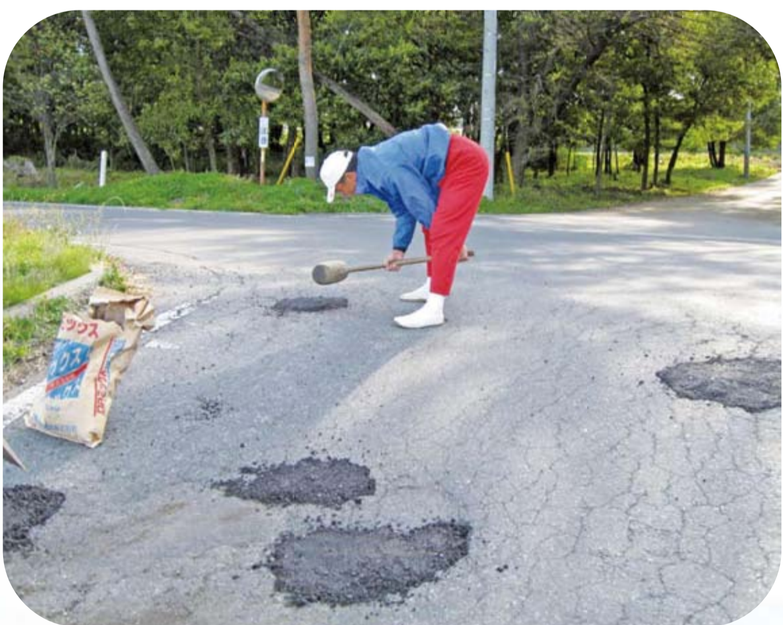
常温アスファルトによる道路補修
