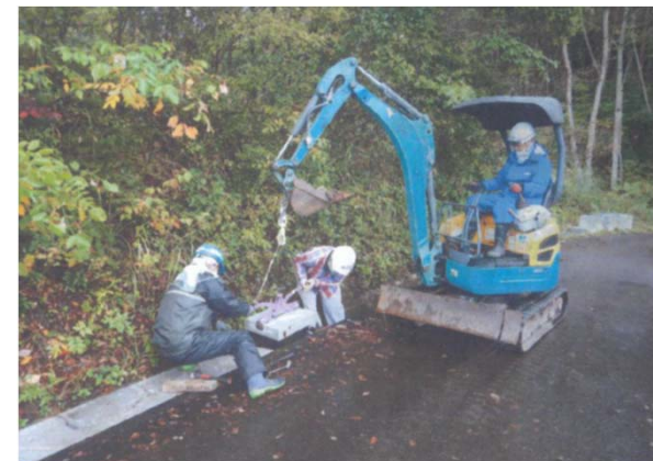
◇溝蓋設置（直営施工）
