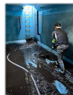
◇ 貯水槽土砂上げ
