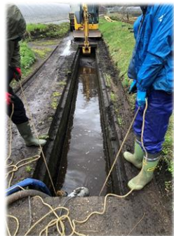
◇ 水路の泥上げ
