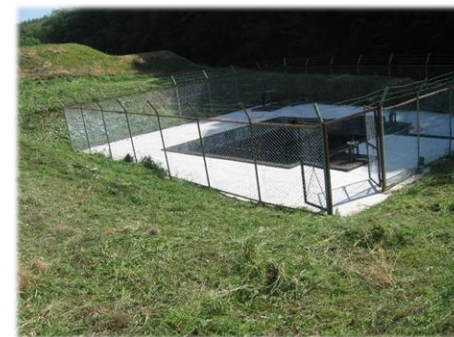
◇ 調整池の堆積土砂撤去活動 ◇ 調整池周りのコンクリート舗装
