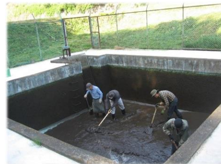
◇ 調整池の堆積土砂撤去活動 ◇ 調整池周りのコンクリート舗装
