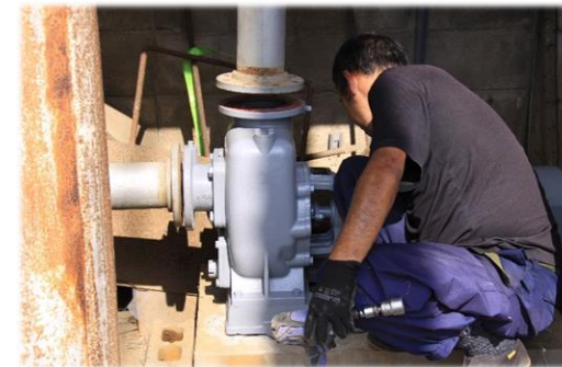
◇ 揚水機更新工事
