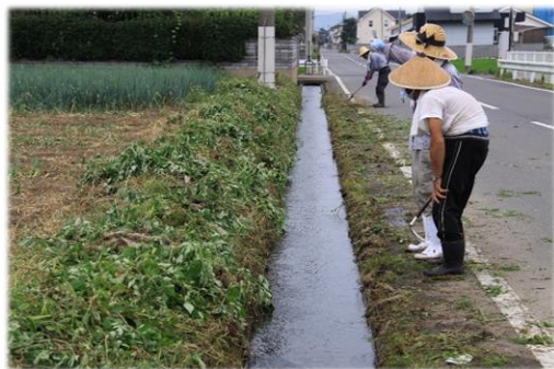
◇ 水路の草刈り作業
