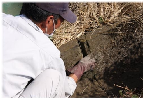
◇ 目地詰め作業風景
