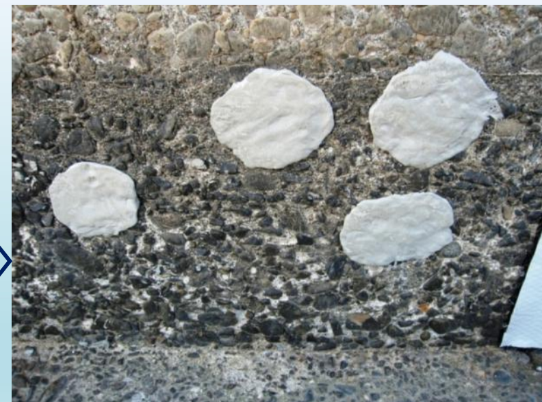
水中パテ施工後
