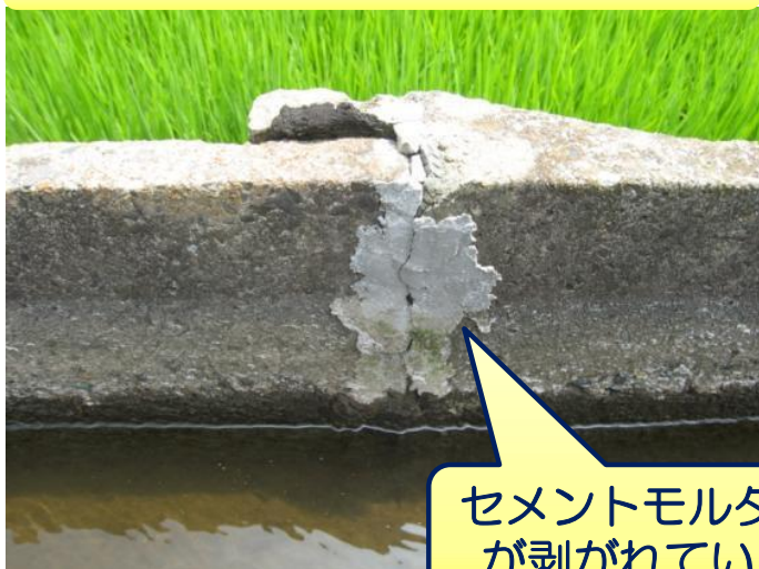
セメントモルタルによる補修
