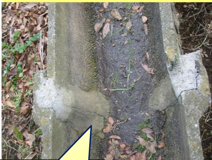
セメントモルタルによる補修
