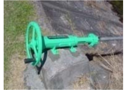
ゲート、バルブの更新
