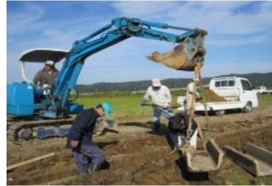
コンクリート水路の更新
